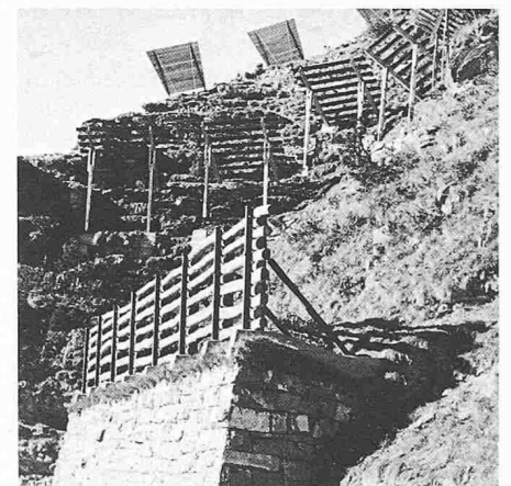
Lawinerverbauungs- und Aufforstungsprojekt Niesen. Beispiel für Entwicklung der Werktypen: 30er Jahre Trockenmauern aus am Ort gewonnenen Steinen; 40er/50er Jahre Erhöhung mit Schnee Hag aus Eisenbahnschienen und Holzdruckrost (unten); ab 60er Jahre Schneebrücken aus Stahl (mitte); Kolktafeln zur Vermeidung der Gwächtenbildung (Foto: W. Schwarz)
