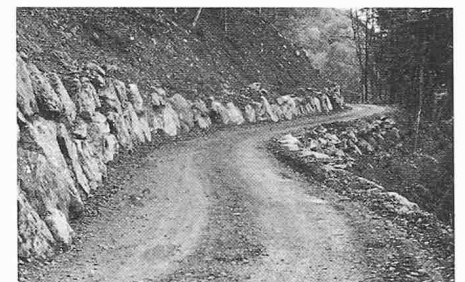
Wyhelfluhweg ob Brienz. Dem Gelände angeglichener Verlauf, Blöcke in Beton verlegt. Foto: FIO
