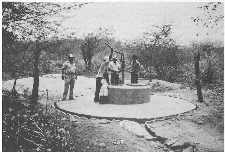
Bild 1. Typische Brunnenanlage: geschlossener, gemauerter Schacht mit Handpumpe und Einstiegöffnung, Mörtelabdeckung und Graben zur Ableitung von verschüttetem Wasser
