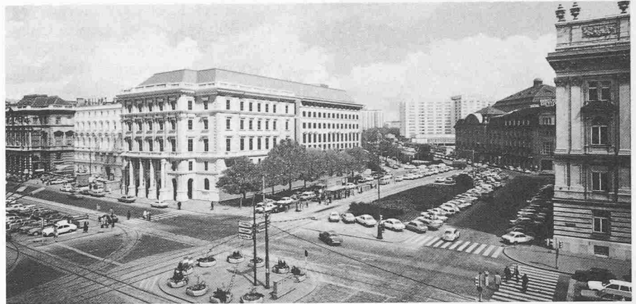
Bild 14. Verwaltungsgebäude der Mobil Oil Austria als Neubau mit historischer Fassade am Schwarzenbergplatz zur Erhaltung des Wiener Stadtbildes
