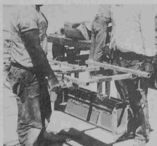
2 Mann tragen Polydrain mit Versetz-einrichtung
