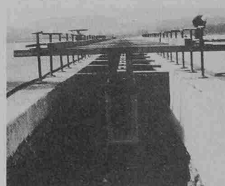
Rinne versetzt, vor dem Betonieren
