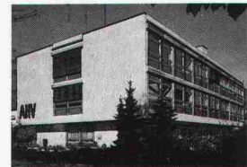
ISOTECH-Arbeitsbeispiel aus dem Bereich Fugenabdichtung: Verwaltungsgebaude der AHV in Chur.
