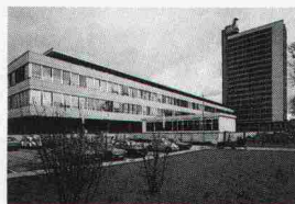
ISOTECH-Arbeitsbeispiel aus dem Bereich Fugenabdichtung: Gebau der PTT-Generaldirektion in Ostermundigen.
