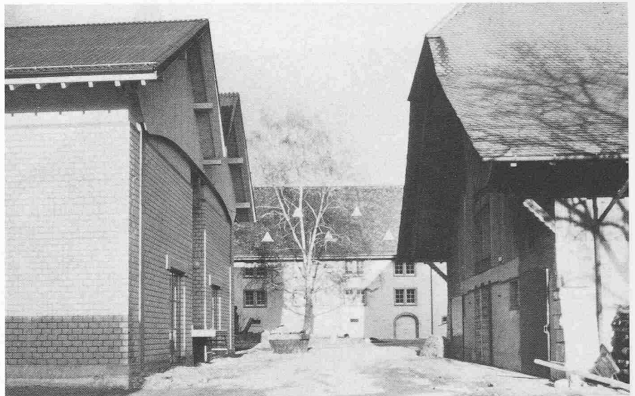
Die Problematik von konsequent neuem Bauen in alter Umgebung führte zu einem intensiven und zeitaufwendigen Dialog mit der historischen Substanz; links das Werkstattgebäude, rechts Stallungen, im Hintergrund das Klostergebäude
