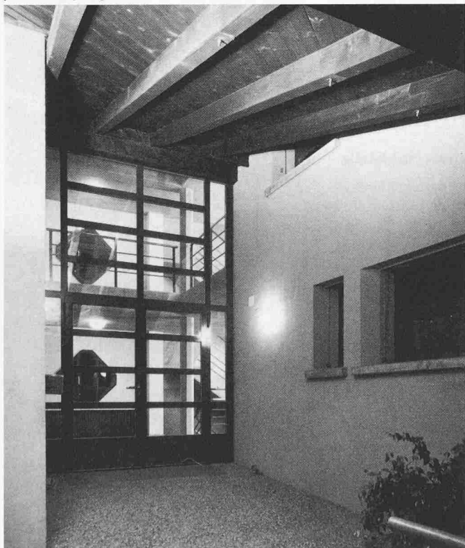
Auf Stahl Türen, Klappbetten und Fenstergitter wurde verzichtet. Die Zimmerfenster bestehen aus einer grossen ausbruchsicheren Öffnung und einem transparenten Lüftungselement
