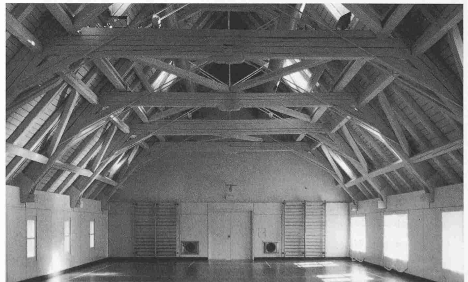
Mehrzwecksaal, Nutzung der grossen Dachvolumen in historischen Bauten
