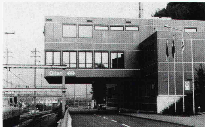
Neues Stellwerk Bahnhof SBB, Oltten, Fahrbahnisoliation
