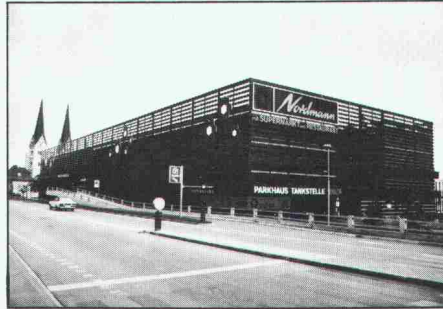
Traggerippe eines Handelszentrums mit Parkebene im Untergeschoss
