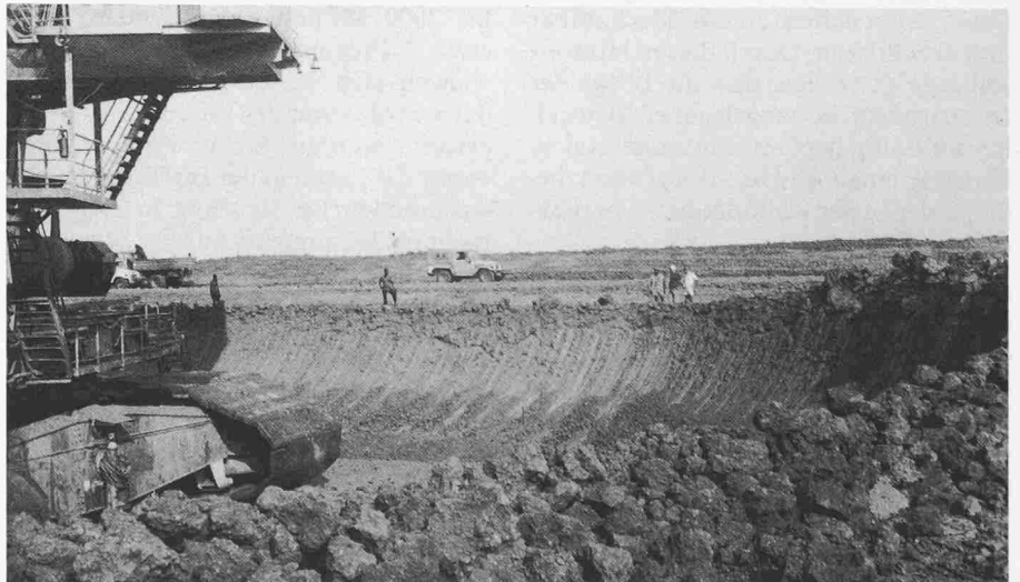
Seitliche Aushubfläche im Kanal. Im Schnitt erscheint (hell) der «cotton soil», darunter (dunkel) der dunkle Mergel. Im Vordergrund liegt der von der Aushubstirne vom Radbagger aufgeworfene Boden. Die seitlichen Aushubflächen werden durch Schaufelbagger auf die bestimmte Böschung abgeschragt
