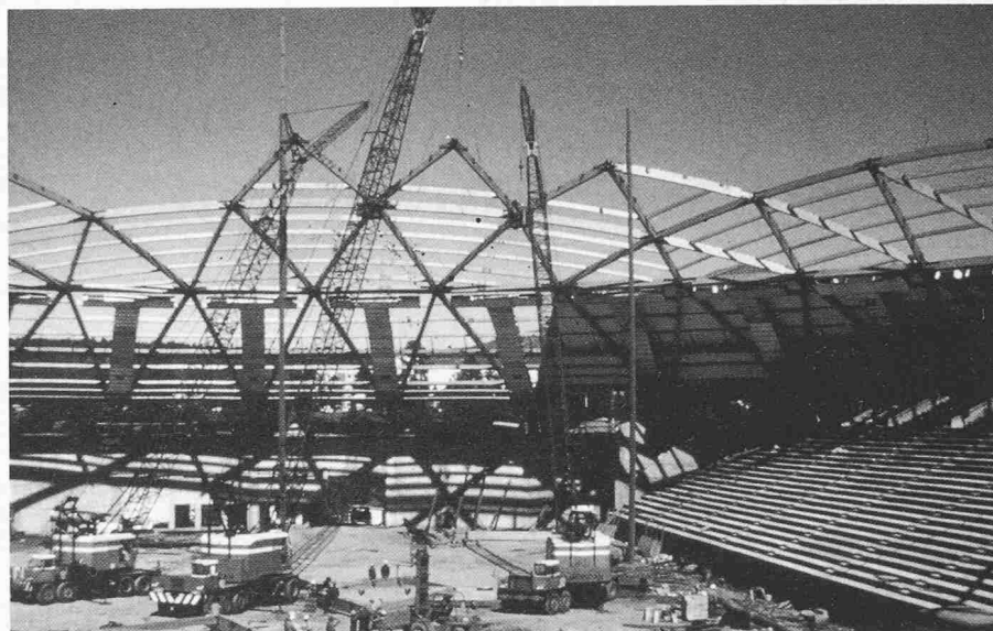
Bild 8. Die leicht anzutransportierenden Elemente werden mit Kranwagen und mit wenigen Hilfsstützen im Freivorbau montiert. Die Zwischenpfetten werden im Takt eingehängt, damit die nachfolgende Schalung befestigt werden kann
