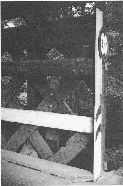
Bild 6. Townscher Träger über den Neckar bei Anzenwil
