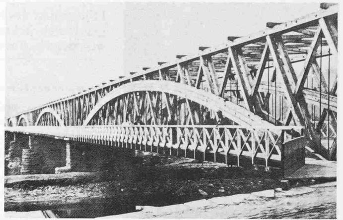
weichungen zwischen Drucklinie und Bogenachse. Einer hohen Biegesteifigkeit des Holzbogens kommt deshalb eine entscheidende Bedeutung zu, was jedoch von den französischen Ingenieuren übersehen wurde. Die relativ schlanken Bögen, aufgebaut z.T. nur aus 3 Lagen mit häufigen Querstössen, wiesen trotz Verbolzung und Verklammerung eine geringe Biegesteifigkeit auf.
