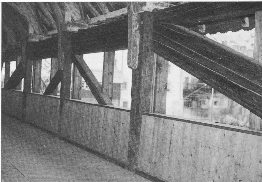
Bild 4. Innenansicht des «Pont de Berne» in Freiburg
