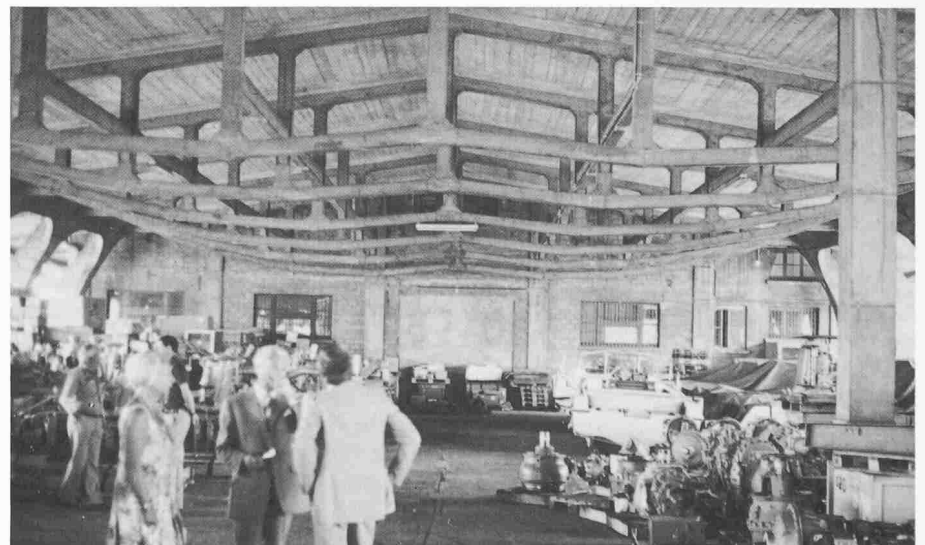
Innenansicht mit den Beton-Fachwerkträgern
