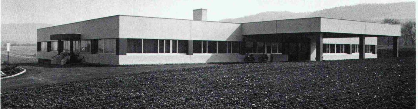
Diese Fabrikationshalle wurde nach den Vorstellungen und Wünschen des Bauherrn mit vorfabrizierten Beton-elementen geplant. Wir haben sie in 14 Tagen montiert. Betonhallen sind solide und sichern der Bauherrschaft eine hohe Wertbeständigkeit.
