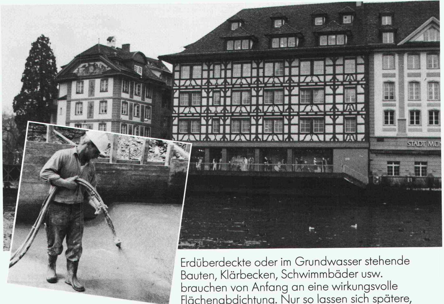
Erdüberdeckte oder im Grundwasser stehende Bauten, Klärbecken, Schwimmbäder usw. brauchen von Anfang an eine wirkungsvolle Flächenabdichtung. Nur so lassen sich spätere, kostspielige Schäden vermeiden.
