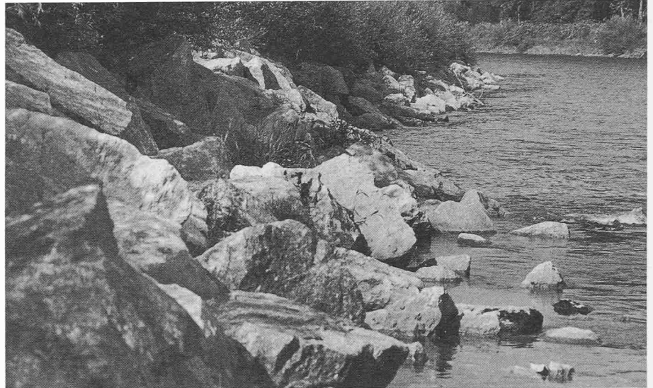
Grosser Blockwurf erschwert Zugang zum Wasser für Mensch und Tier (Heimatschutzgesellschaft Winterthur)
