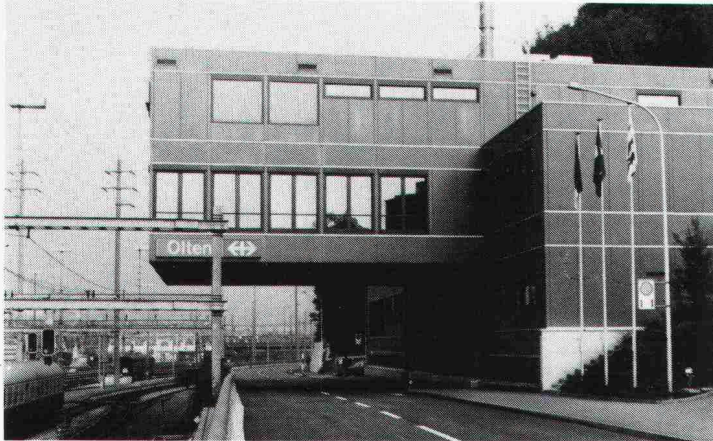
Neues Stellwerk Bahnhof SBB, Olten, Fahrbahnisolation
