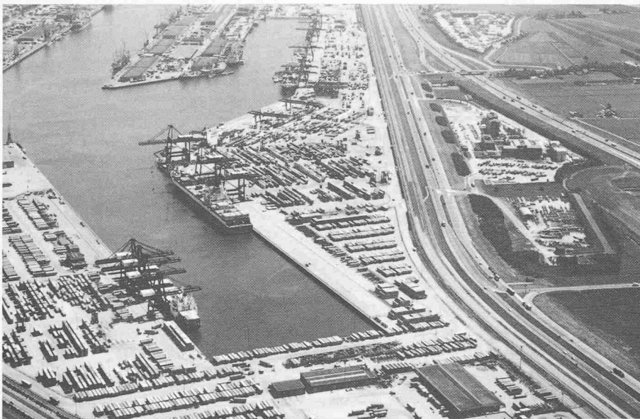
Bild 3. Container-Terminal im Eemshaven in Rotterdam mit 1,1 Mio. m 2 Umschlag- und Lagerflächen - befestigt wie in Bild 2 gezeigt
