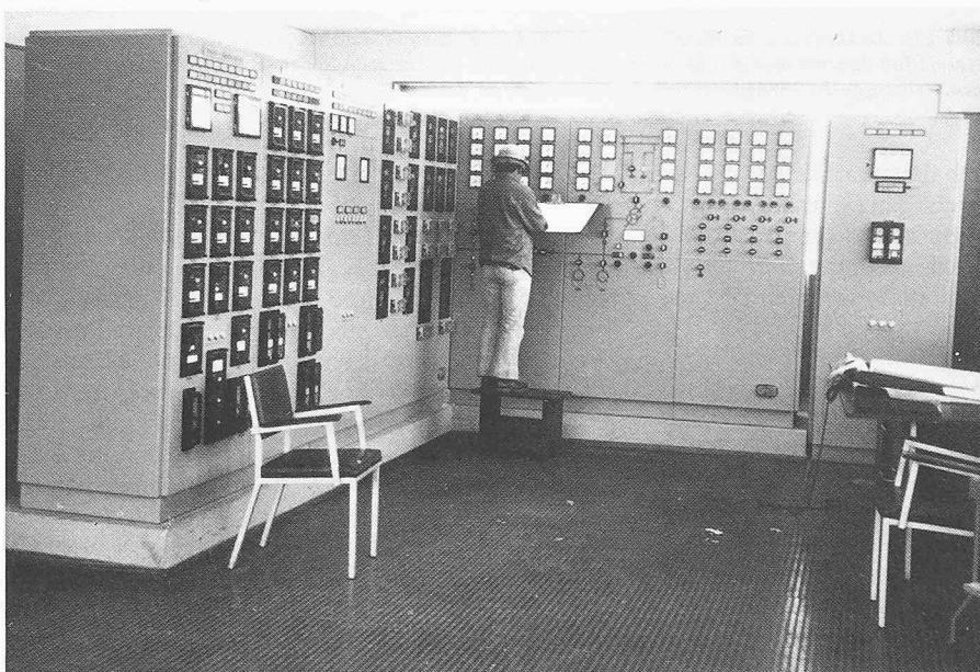
Bild 20. Zu hoch angeordnete Instrumente
