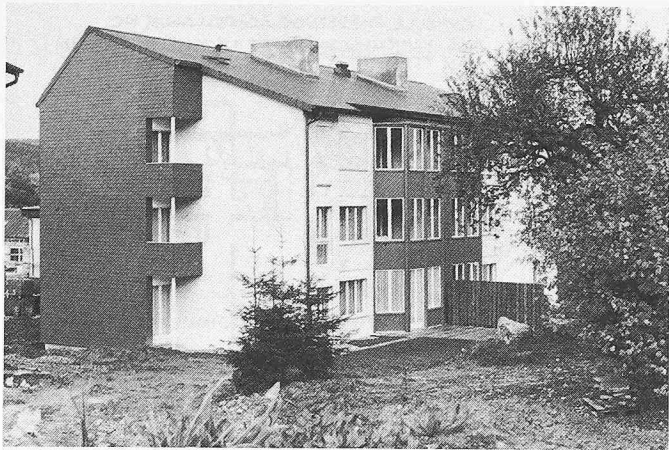
Bild 8. Südfassade mit Wintergarten
