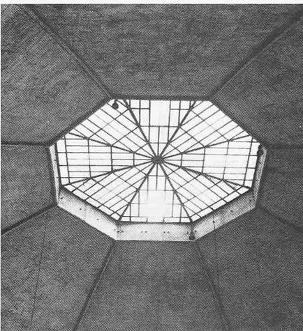
Bild 11. Markthalle in Basel, 1928, Architekt *H.E. Ryhner*. Achteckige Kuppel des Schalgewölbes in Eisenbeton.
