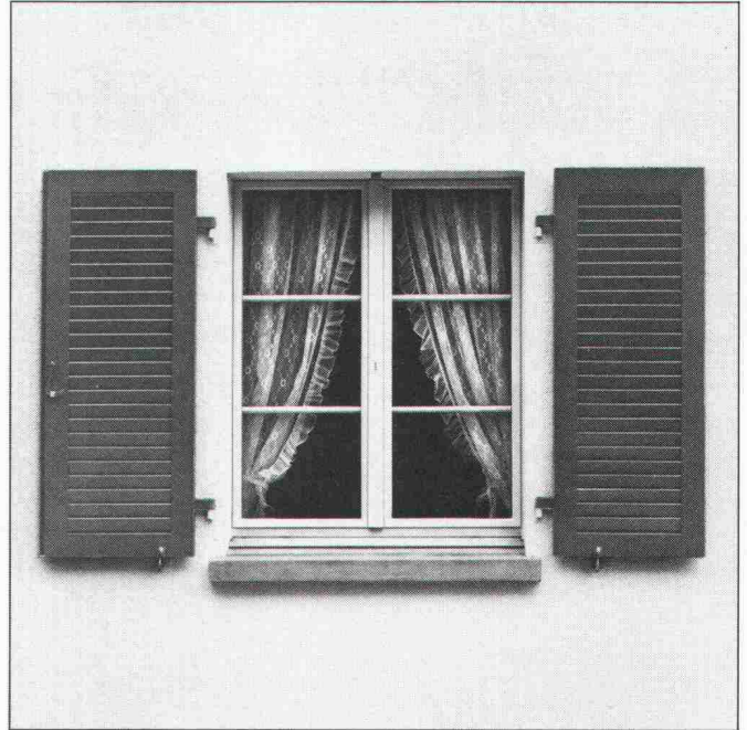
Haus mit aussenisolierter Fassade. Man sieht es nicht.
