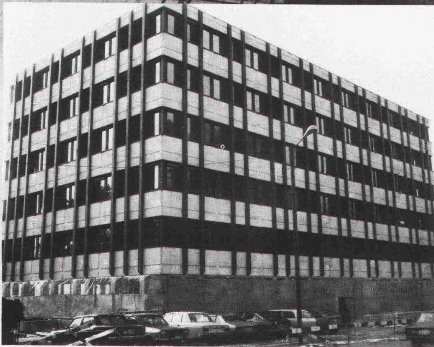
Verwaltungs- und Geschäftsgebäude der Publicitas AG, Lausanne. Dieses Bauvorhaben war bei der WAADT versichert.
