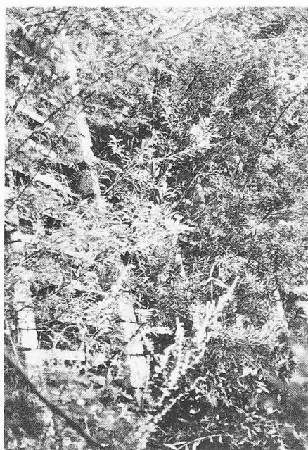
Bild 3. Beton-Krainerwand mit Buschlagen, etwa 10jährig
