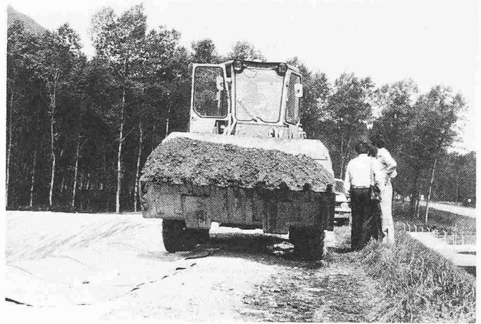
Bild 10. Demonstration der Durchschlagsfestigkeit der verwendeten KDB aus Sarnafil FP. Der beladene Trax fährt über die auf Kiesboden verlegten 2 mm starken KDB, ohne dass diese irgendwie beschädigt werden
