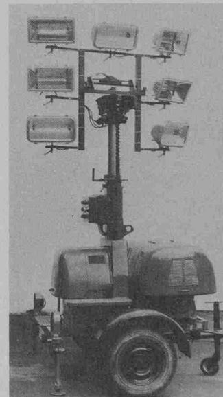
Stellen ist das Gerät auch ohne Zugfahrzeug zu verschieben. Die Abstützungen gestatten eine standsichere Aufstellung bis Windstärke 9. Der ausgefahrene Teleskopmast ist im 180°-Bereich drehbar.
