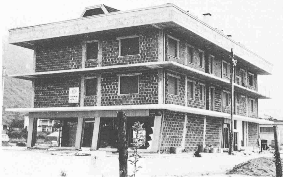
Schäden an einem Wohn- und Geschäftshaus bei Artegna als Folge des Friaul-Erdbebens vom 6. Mai 1976. Die zwei oberen Stockwerke haben sich gegenüber dem untern um das Treppenhaus verdreht (maximale Verschiebung 35 cm). Während die oberen Stockwerke unbeschädigt blieben, ist das Erdgeschoss stark beschädigt. Der Schaden ist durch die geringere Steifigkeit im Erdgeschoss gegenüber der in den beiden höheren Stockwerken bedingt
