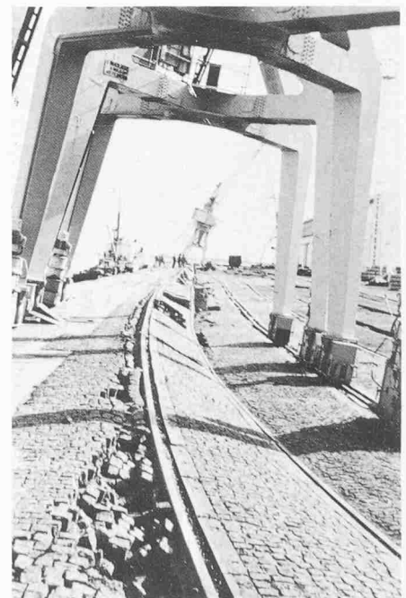
Bild 4. Setzung einer Hafenanlage infolge von Bodenverflüssigung beim Montenegro-Erdbeben vom 15. April 1979
