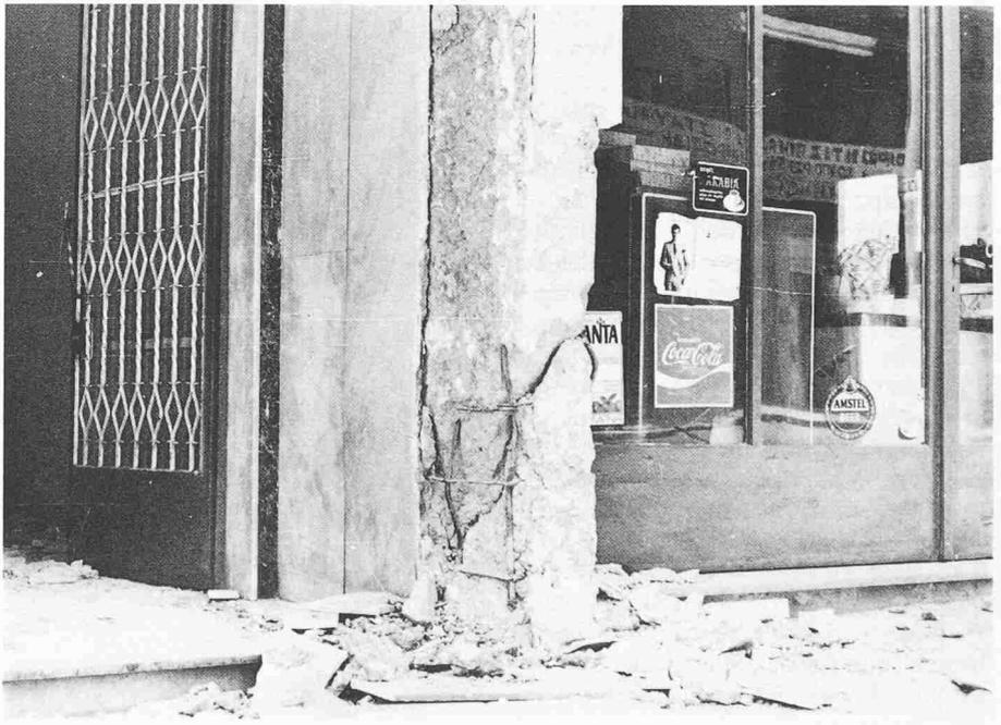
Geknickte Stützen der Tragkonstruktion, etwa 50 cm über dem Erdboden
