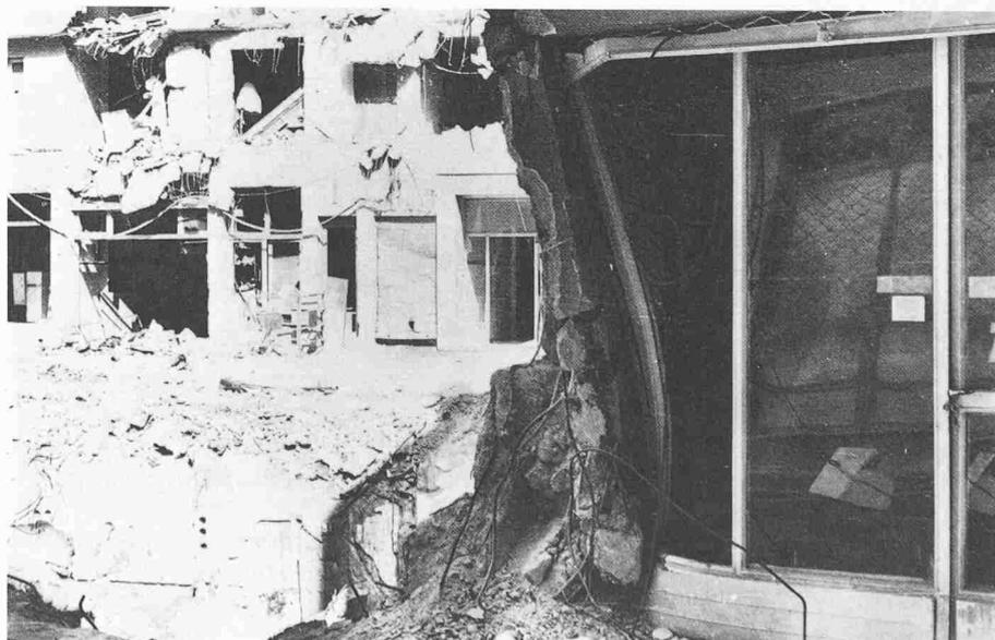
Schäden, verursacht durch den Einsturz des benachbarten Gebäudes, aber auch durch die direkte Einwirkung des Erdbebens (Knicken einer Tragwand)
