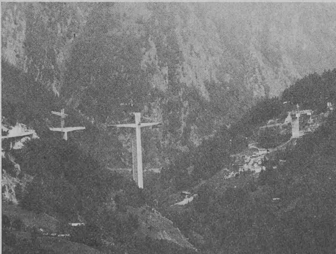
Auf einer Länge von 678 m wird die Ganterbrücke das Gantertal überqueren. In der Bildmitte der mit 148 m höchste Pfeiler 3. Noch nicht sichtbar ist rechts davon Pfeiler 4, der in den geologisch heiklen, linksufrigen Kriechhang zu stehen kommt und deshalb auf einem ca. 40 m tiefen Schacht fundiert wird
