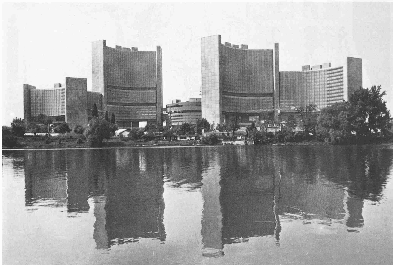
Blick von Südosten. In der Mitte halb verdeckt das Internationale Konferenzgebäude, rechts und links die Amtssitzgebäude für Internationale Organisationen
