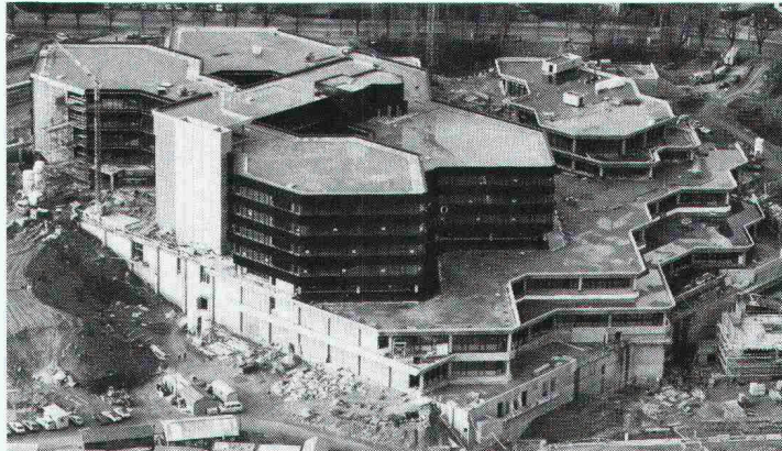
SKA-Neubau Uetlihof Zürich 28'000 m 2 Sarnafil
