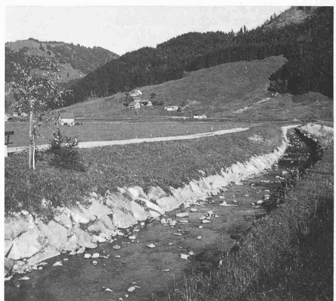
Unterlauf: Blockwurf und Blockschwellen mit Niederwasserrinne und Vorland in landwirtschaftlich genutzter Zone
