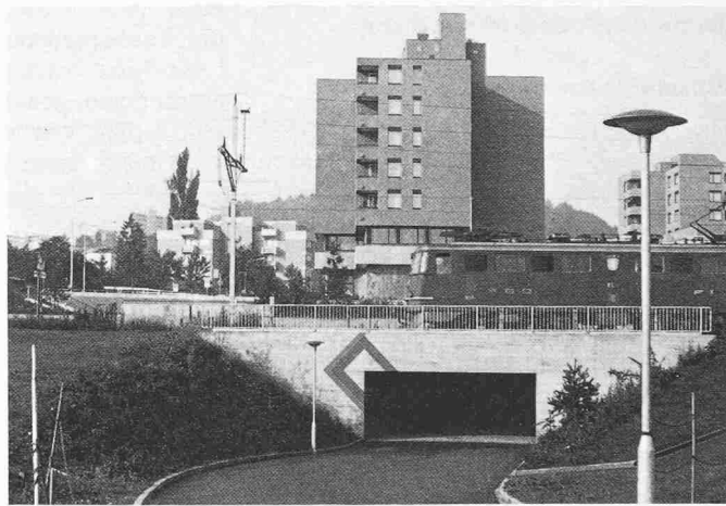
Personenunterführung Riedhaldenstrasse. Nordausgang
