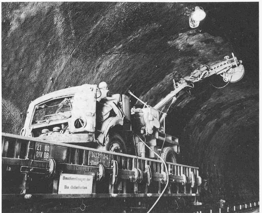
Bild 5. Herstellen von Doppelschnitten für Entwässerungsleitungen in einer Tunnelleibung. Steinsägemaschine mit Teleskoparm
