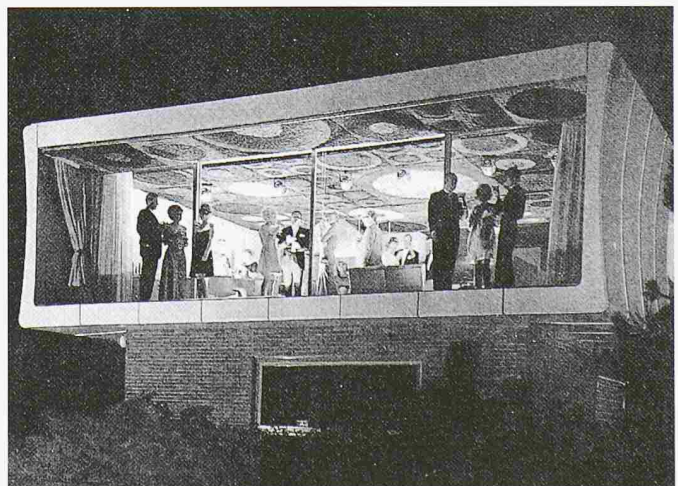
Feierbach-Haus fg2000 aus GFK, Albstadt, Hessen, 1968, (Quelle: Ludwig M.: Mobile Architektur. DVA Stuttgart, 1998)
