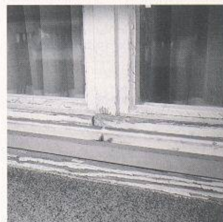
Bild 1. Teilerneuerung, Instandsetzung oder Ersatz? Der richtige Entscheid ist immer mehr auch von Umwelt- und Umfeldbedingungen abhängig. Der unterschiedliche Zustand aller Gebäudeelemente ist Chance, aber auch Gefahr, durch die Wahl zweckmässiger Massnahmepakete ein optimales Erneuerungsergebnis zu erreichen oder zu verpassen
