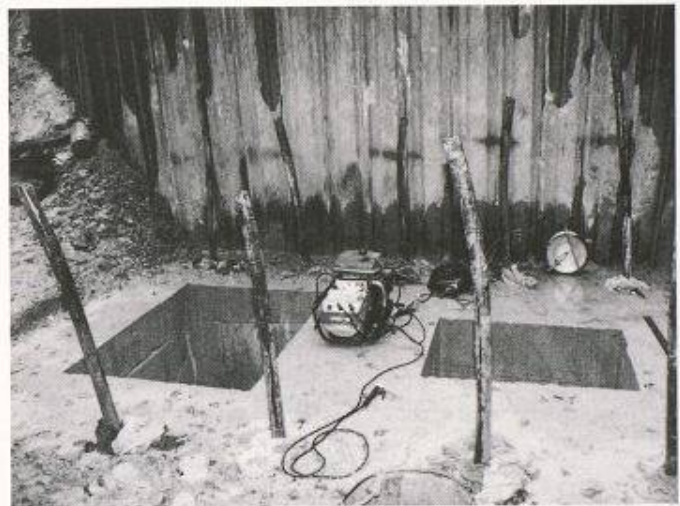
Bild 8. Köcherfundament mit Litzankern
