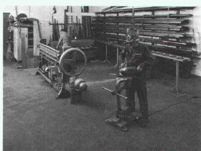
Werkhalle der Geberit AG, Jona
