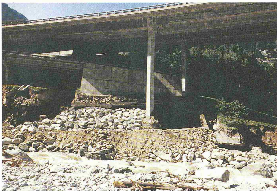
Bild 12. 15000 m 3 Stein- und Steinbruchmaterial; gelungene Unterstellung von Widerlager und Stützmauer am 29.8.1989, Mitternacht Bildautor: T.R. Schneider, 1879/8
