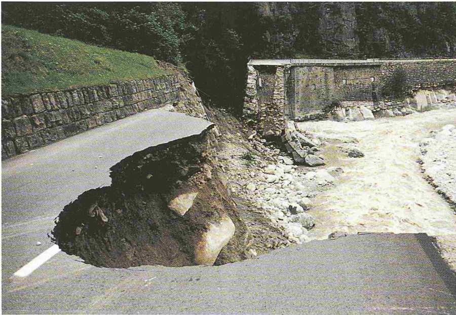
Bild 9. Meienreussbrücke und erodierte Kantonsstrasse Bildautor: T.R. Schneider, 1878/6
