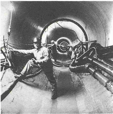
Bild 1. Zentralsammler aus vorgepressten Grossrohren mit Zwischenpressstationen (Nussbaumer)
