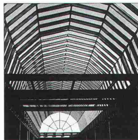
Hochbaukonstruktion (Unternehmensbereich Stahlbau)
