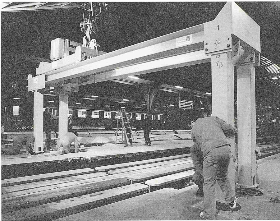
Bild 4. Aufstellen des Portalrahmens
