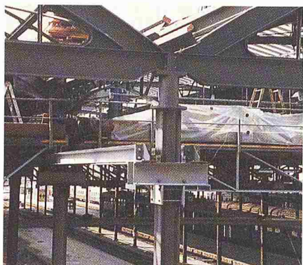
Bild 4. Nördliche Hallenverlängerung mit Schutz- und Arbeitsbühne
