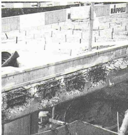
Bild 8. Enge Platzverhältnisse auf der Bankettseite
