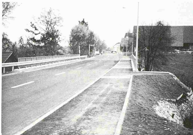
Bild 12. Die umgebaute Brücke aus ähnlichem Standpunkt wie Bild 2
