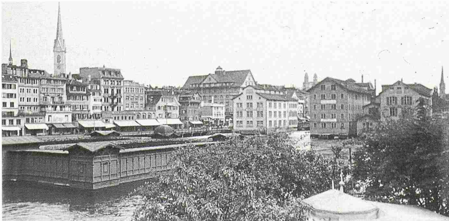
Limmatraum zwischen Bahnhofbrücke und Rudolf-Brun-Brücke 1937. In Bildmitte rechts das alte EWZ-Gebäude
