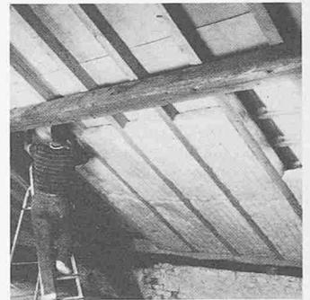
sen als der lichte Abstand der zu isolierenden Felder. Diese Platten werden alsdann zwischen die Sparren oder Felder geklemmt und tragen sich selbstständig durch eine ausserordentliche Klemmkraft.
