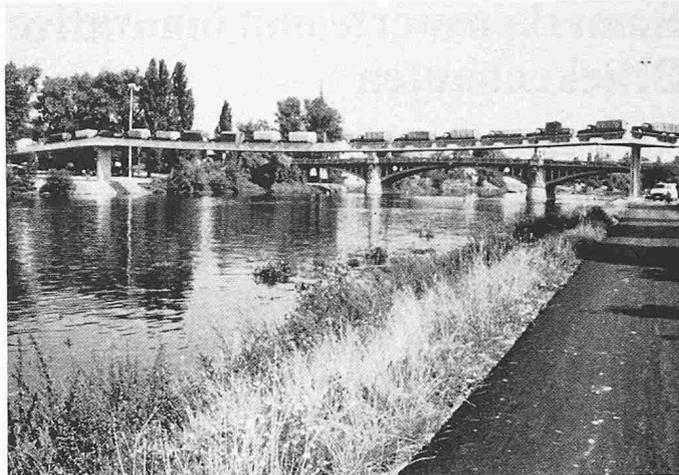
Bild 9. Spannbänderbrücke in der CSSR bei der Probelastung
