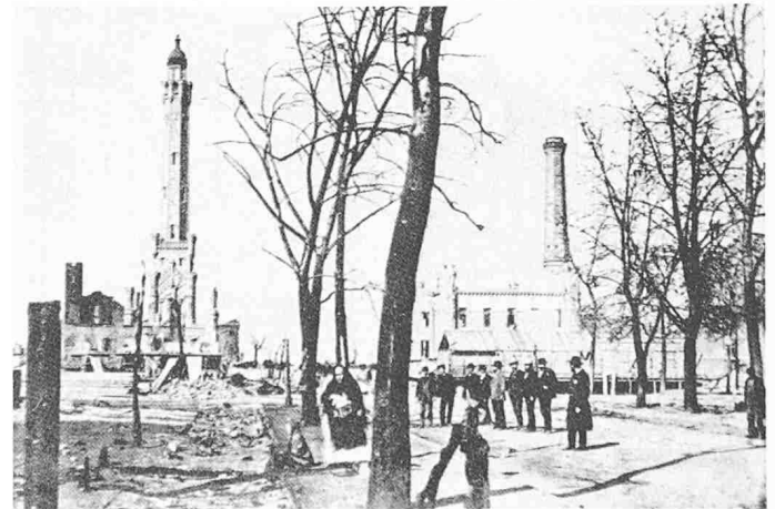
Nur der Wasserturm überlebte den Brand
