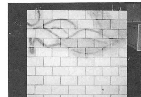
Bild 5. Probewand, behandelt mit dem Produkt A. Nach der Reinigung, Versprayedungen immer noch sichtbar
