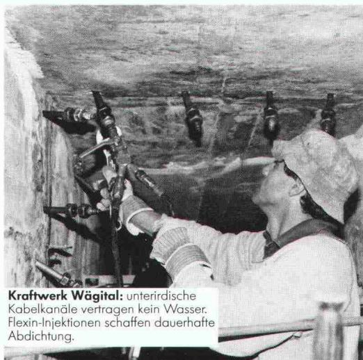
**Kraftwerk Wägital:** unterirdische Kabelkanäle vertragen kein Wasser. Flexin-Injektionen schaffen dauerhafte Abdichtung.
